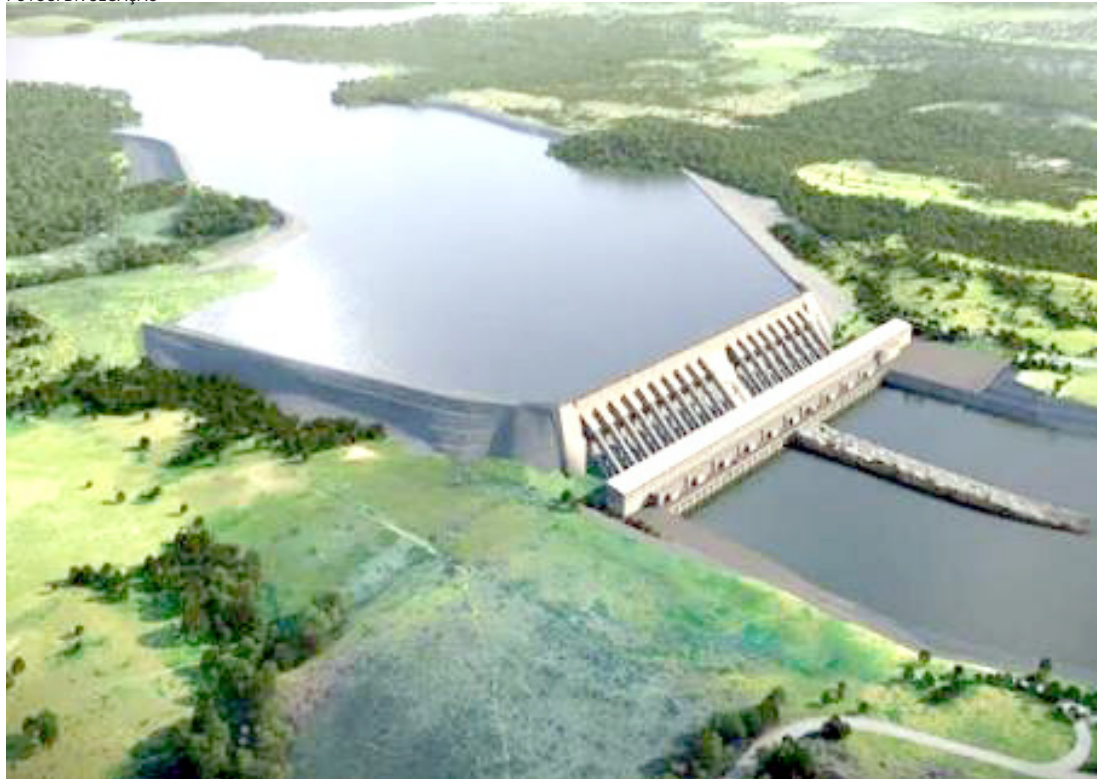
Falha no sistema da Usina de Belo Monte, no Pará, foi a causadora do apagão que atingiu 13 estados
