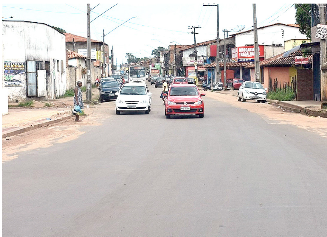
Avenida Tancredo Neves pavimentada melhorou o acesso às cidades de Paço do Lumiar e São José de Ribamar
