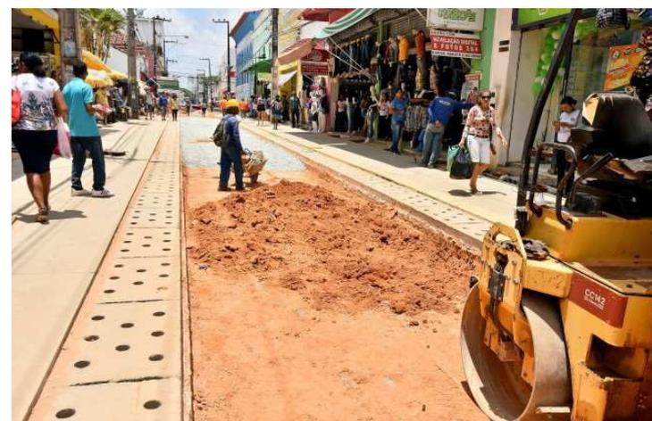
rede de distribuição de água, de esgotamento sanitário e instalação de novas ligações domiciliares. Após, inicia obras de construção da infraestrutura da rede subterrânea de energia e demais serviços de acabamento e pavimentação.
