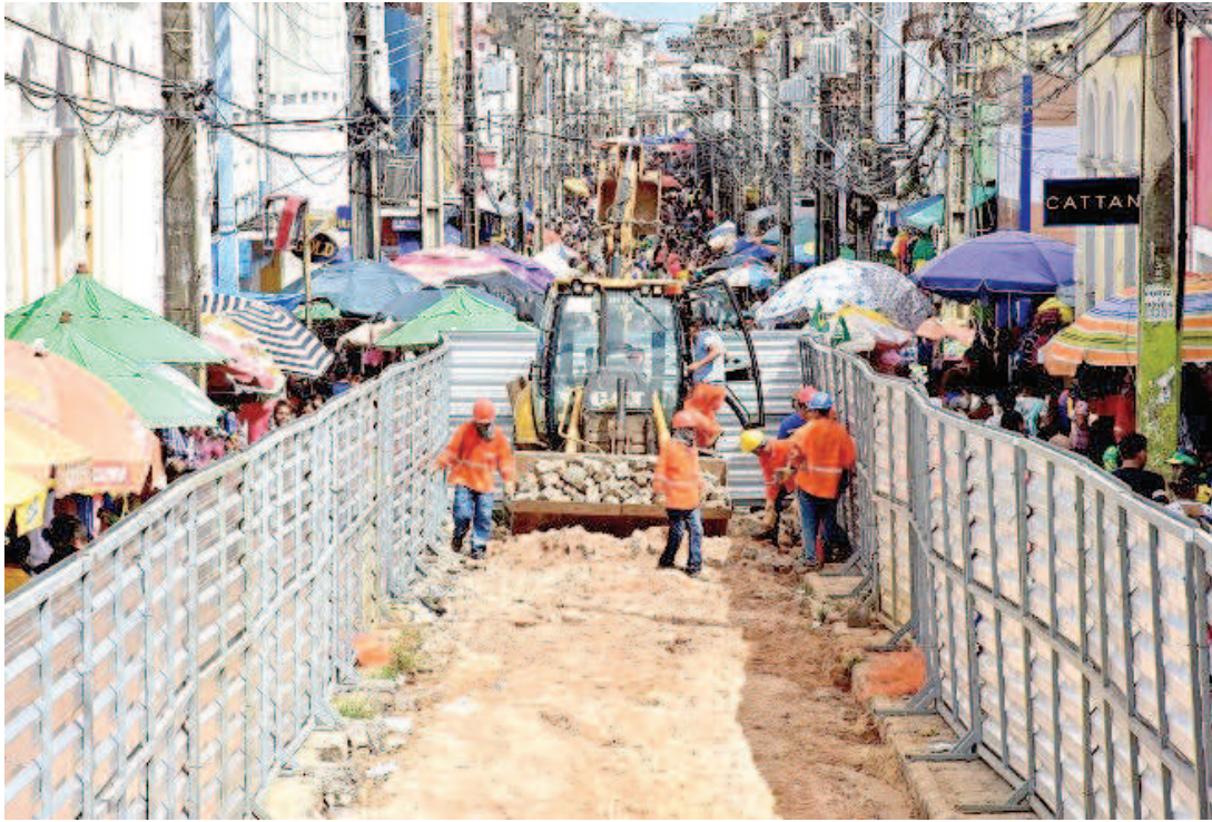
Toda a infraestrutura subterrânea das ruas do Passeio e de Santaninha já foi executada na primeira quadra
