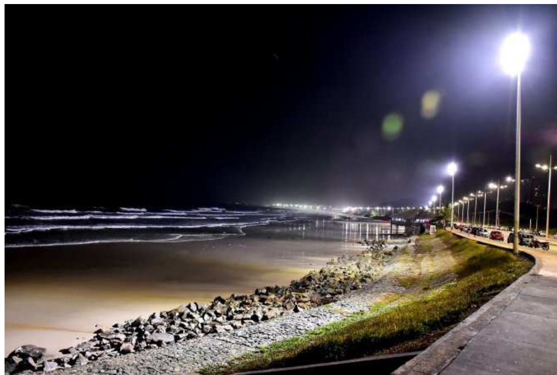
O trabalho consiste na substituição de postes e instalação de novos projetores ao longo de toda a via
