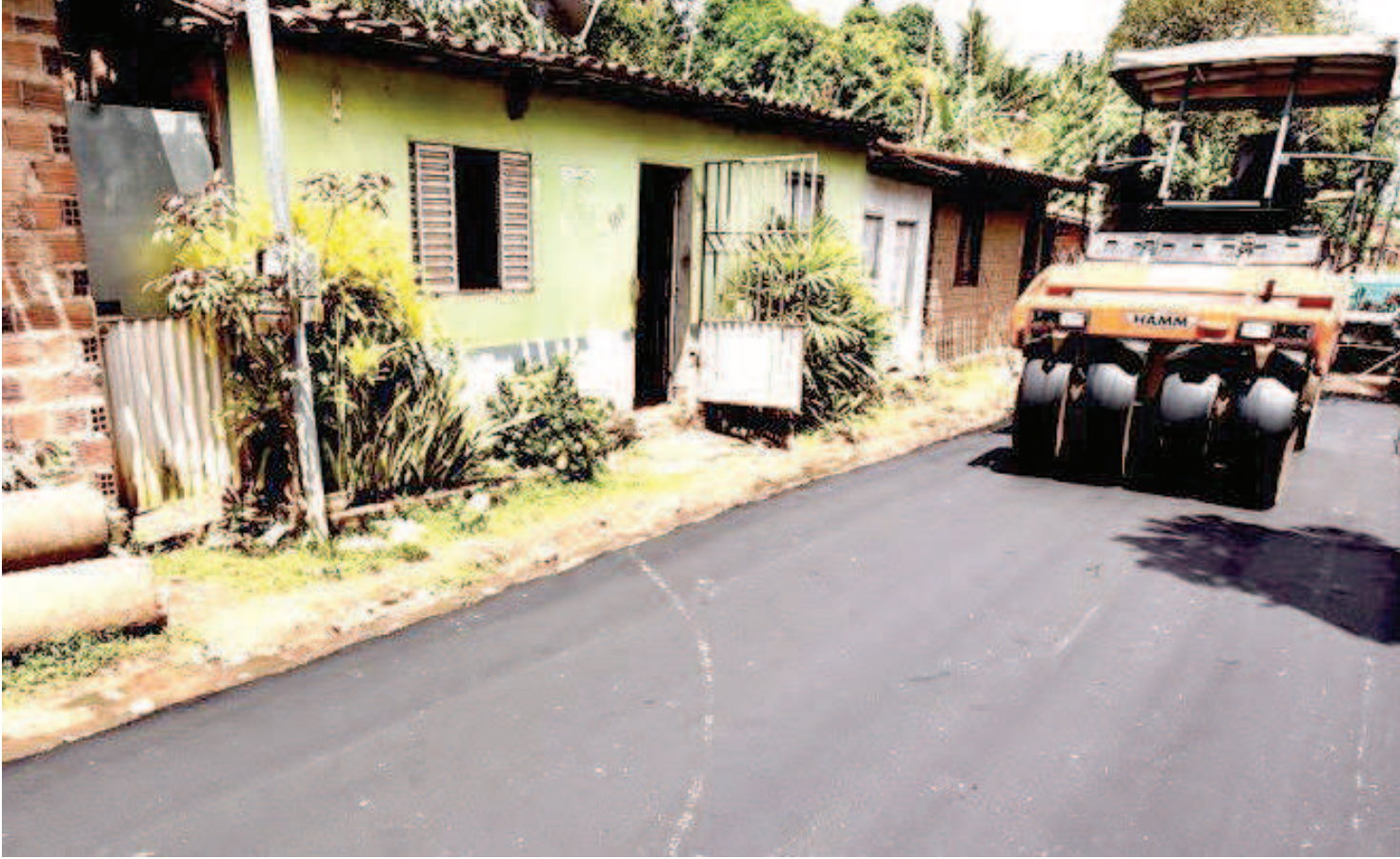
Rua do Meio, na Estiva, está recebendo obras da Prefeitura de São Luís. A maioria das ruas do bairro nunca havia recebido asfalto
