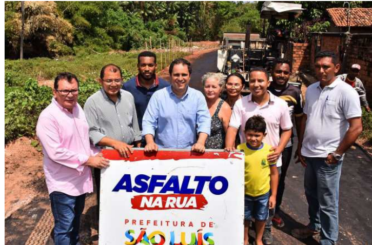
Prefeito Edivaldo vistoria obras de infraestrutura nos bairros da capital
