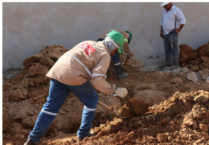
Obras do lema estão sendo realizadas pela Secretaria de Infraestrutura
