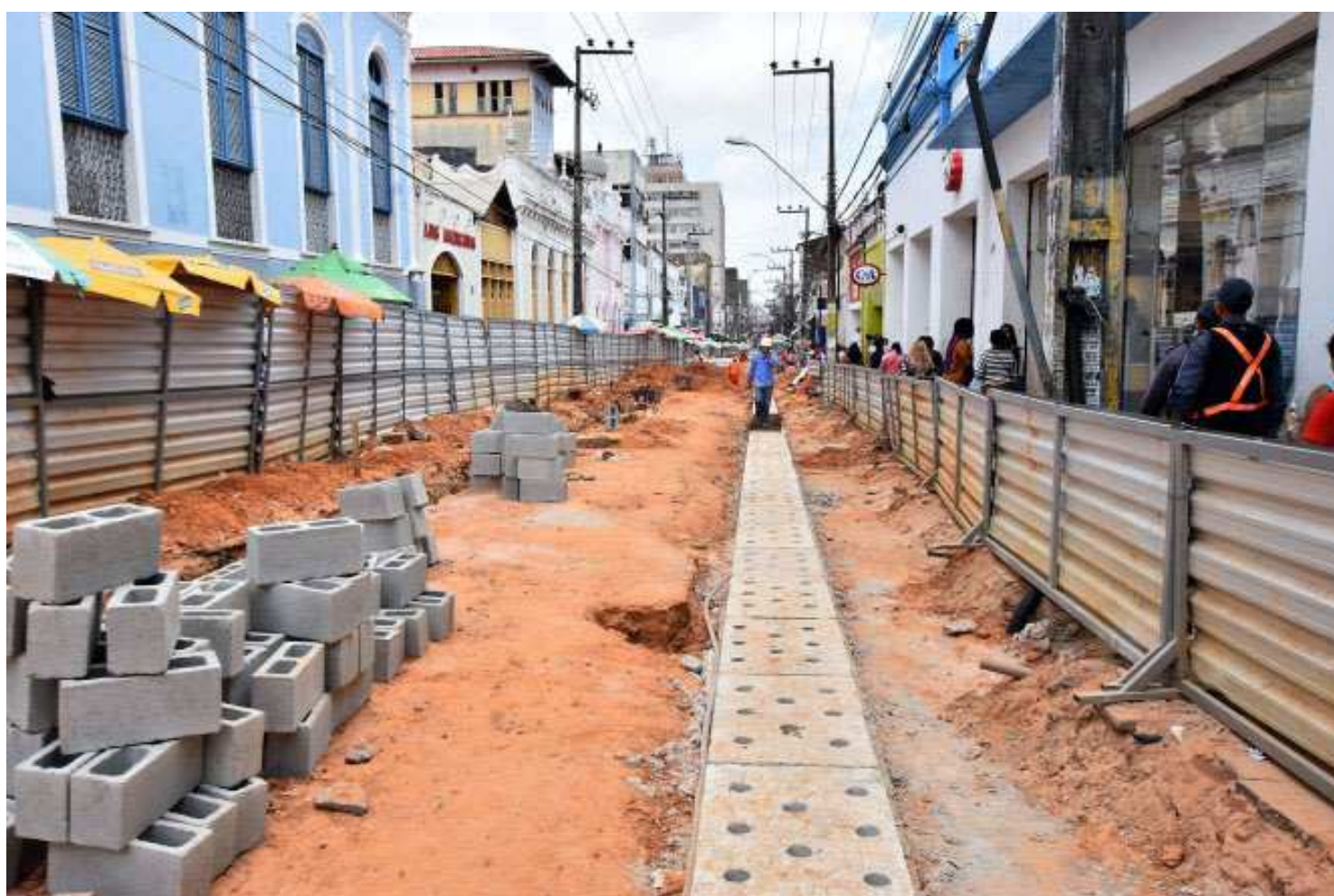
Realizadas pelo Iphan e Prefeitura, obras da Rua Grande avançam nas três primeiras quadras da via, que será totalmente revitalizada
