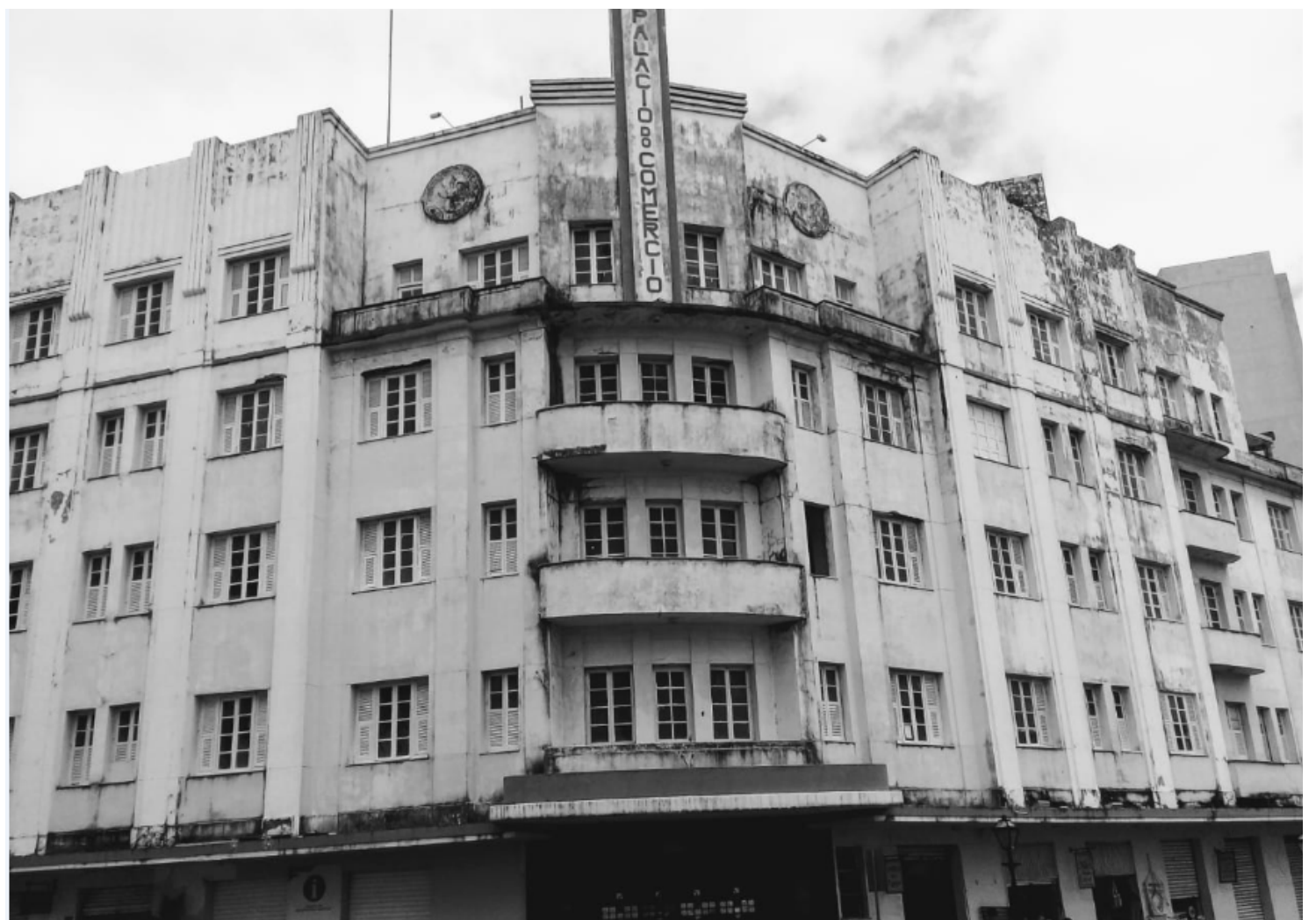
O Hotel Central, por muitos anos, funcionou no prédio do Palácio do Comércio
