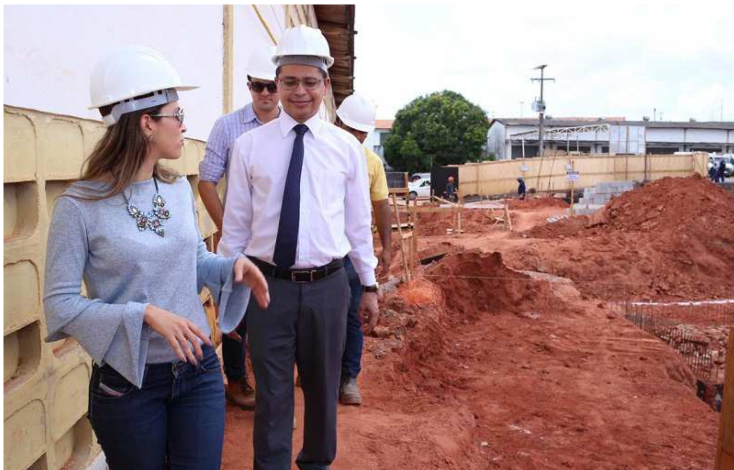
O secretário de Estado da Saúde, Carlos Lula, visitou a obra de construção do espaço destinado para a instalação do aparelho de radioterapia
