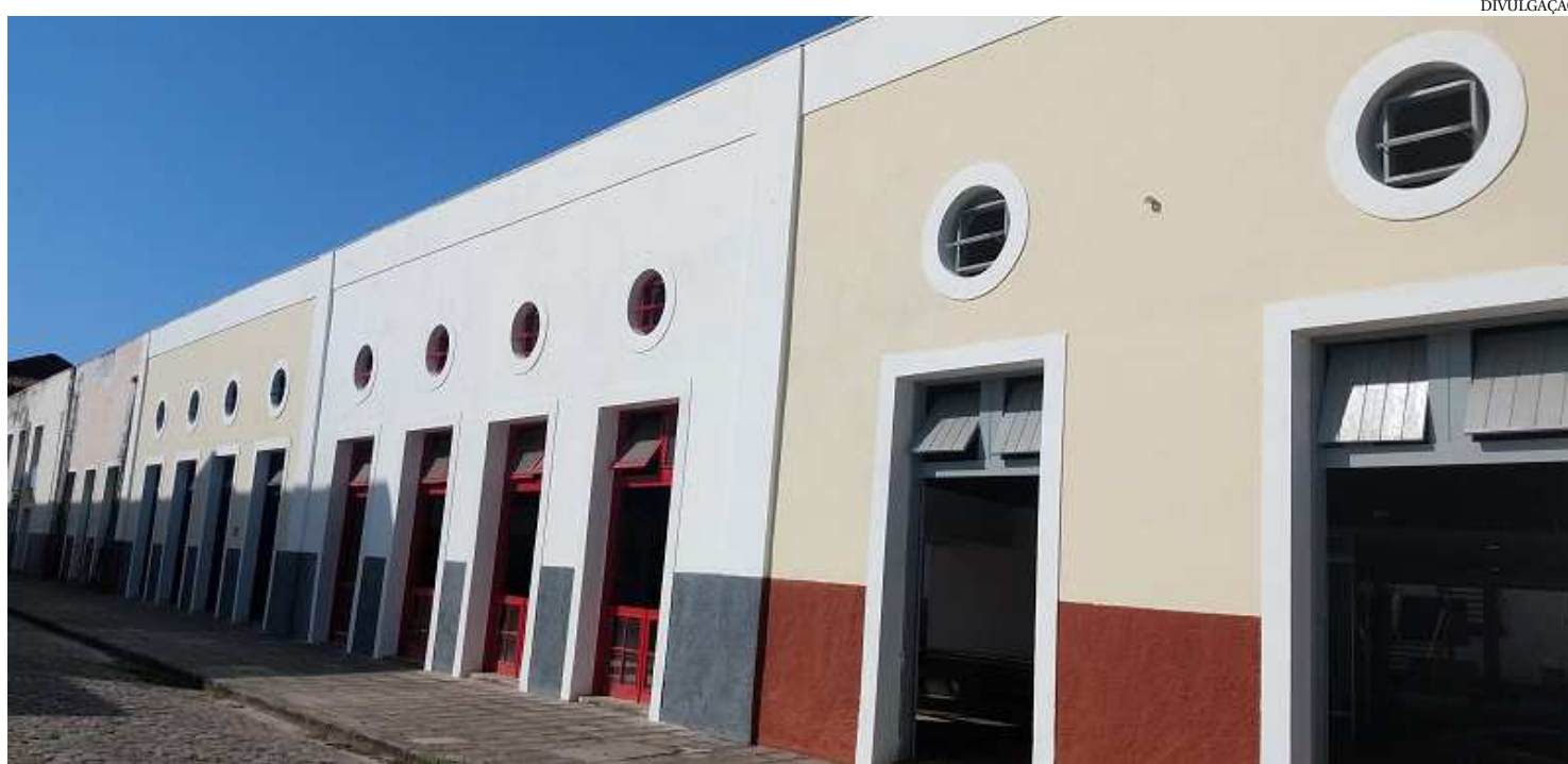
MORADA DAS ARTES PASSOU POR UMA REVITALIZAÇÃO NAS INSTALAÇÕES ELÉTRICAS E HIDROSANITÁRIAS EM SUA INFRAESTRUTURA
