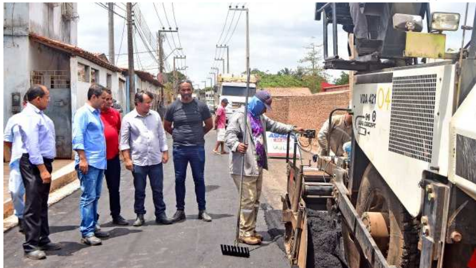
PREFEITO EDIVALDO INTENSIFICA OBRAS ESTRUTURANTES NO BAIRRO SANTA CLARA
