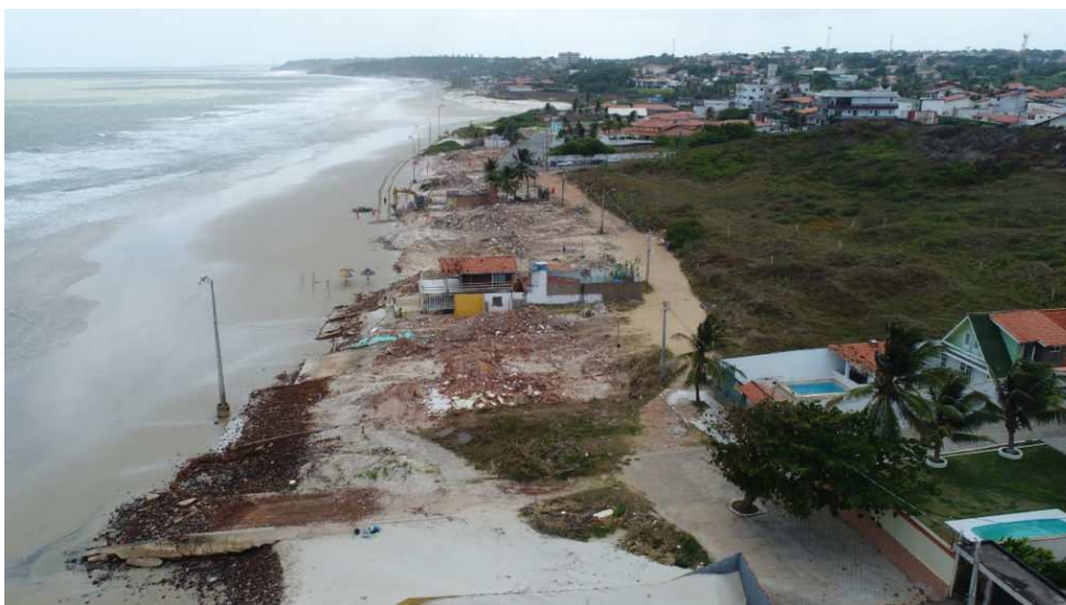
AVENIDA LITORÂNEA CONTARÁ COM UMA VIA EXCLUSIVA PARA A INSTALAÇÃO DO BRT
