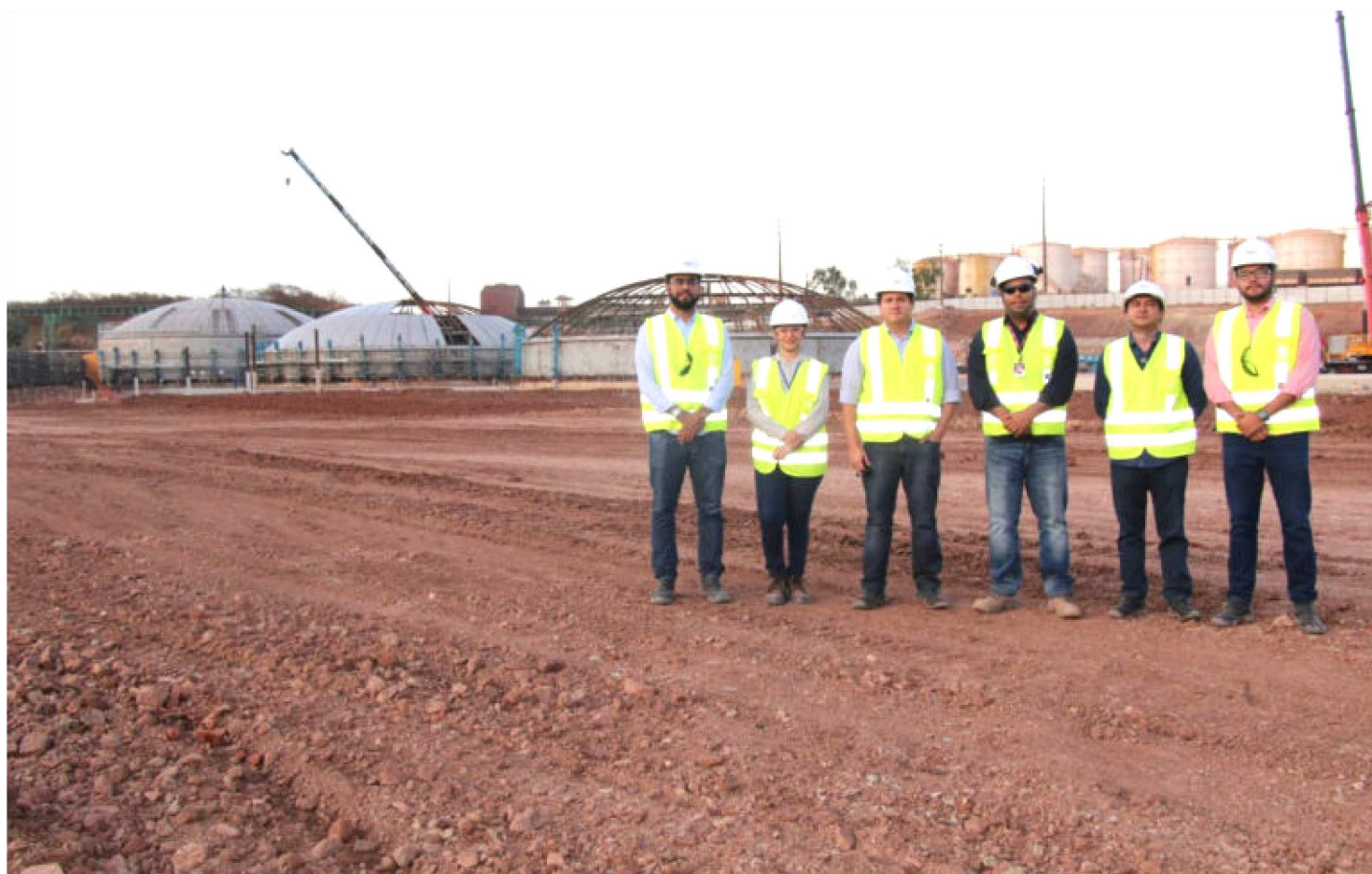
EQUIPE DA SEINC REALIZOU VISITA TÉCNICA ÀS OBRAS DO TERMINAL DE COMBUSTÍVEIS DA RAÍZEN
