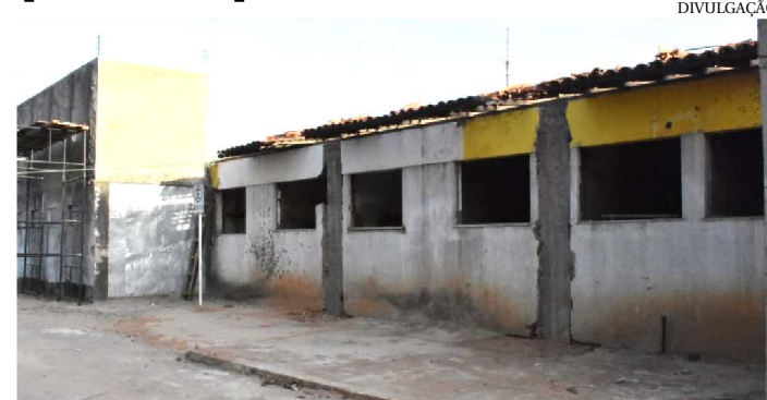
A UNIDADE MISTA PASSA AGORA PELA FASE DE ESTRUTURA
