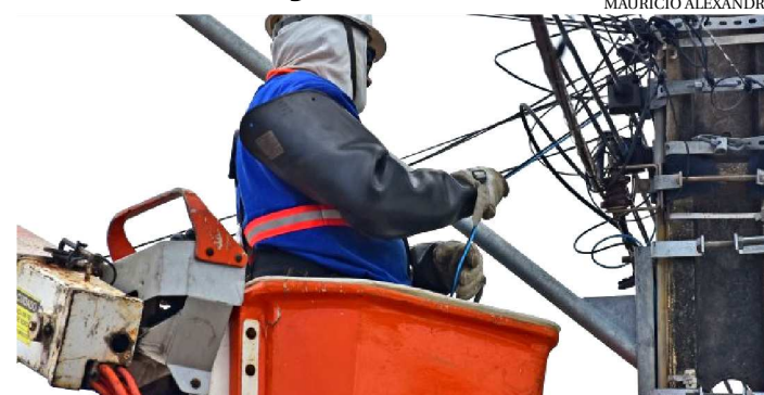
PREFEITURA MODERNIZA ILUMINAÇÃO EM DIVERSOS BAIRROS
