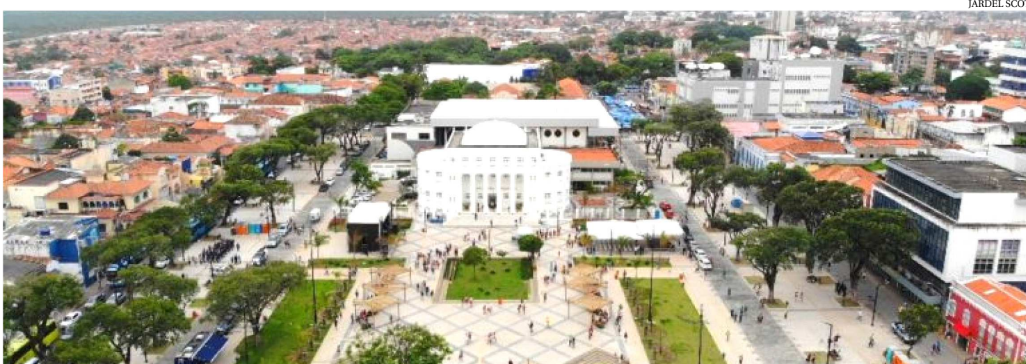
FORAM ENTREGUES O COMPLEXO DEODORO E A PRIMEIRA ETAPA DE REQUALIFICAÇÃO DA RUA GRANDE, CENTRO DA CAPITAL
