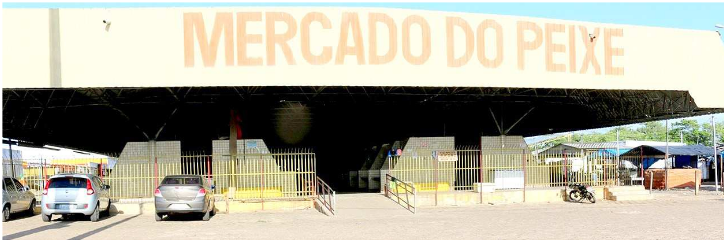
O Mercado do Peixe, no Portinho, passa por readequação com a troca do teto e mudança de piso. Entorno deve ser melhorado nos próximos dias
