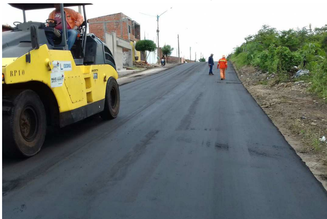
Diversas ruas do município de Caxias receberam um novo recapeamento asfáltico nos últimos dias
