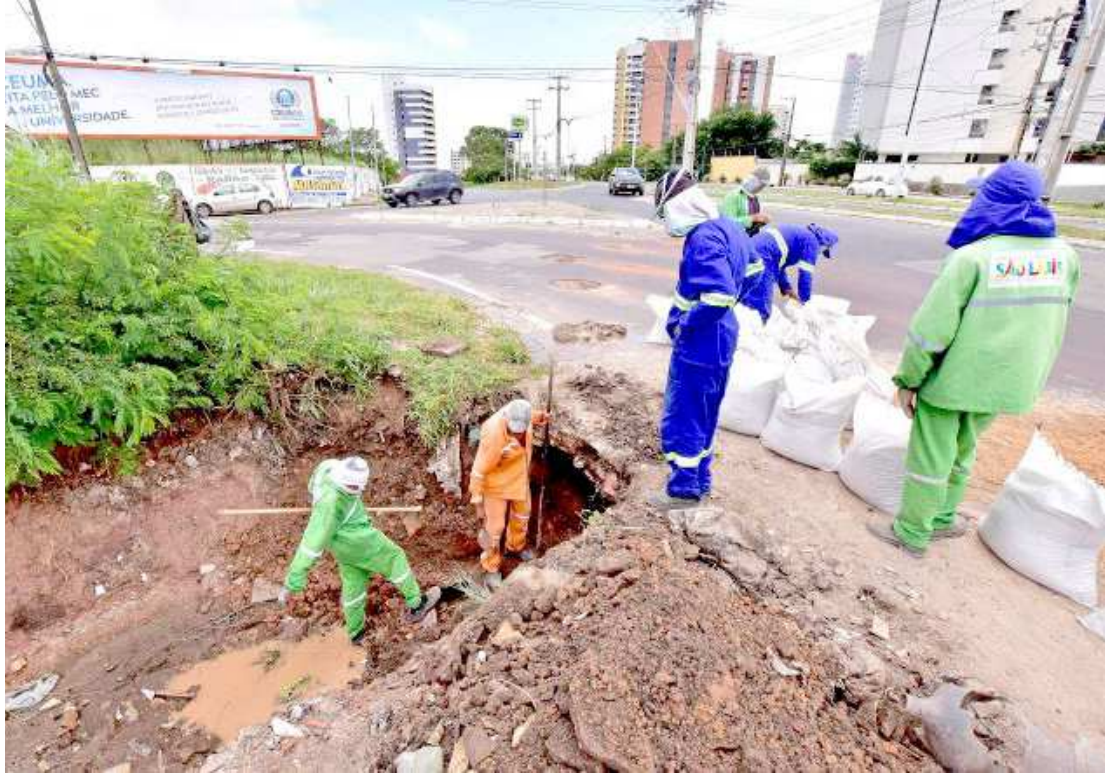
Prefeitura de São Luís realiza tarefa de desobstrução para evitar a erosão na Avenida dos Holandeses
