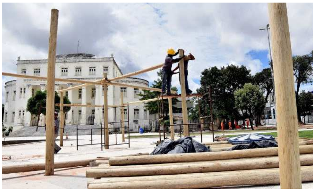
Os caramanchões estão sendo erguidos com hastes de eucalipto autoclavado e medem 16 metros quadrados
