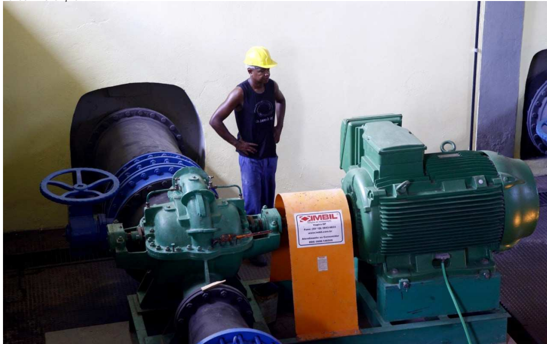
Estrutura nova e reforçada vai acabar com os rompimentos que causavam interrupção no abastecimento
