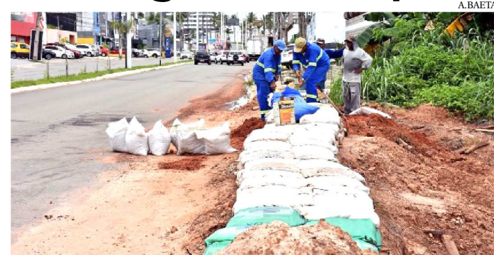
SACOS DE CIMENTO COM AREIA EVITAM O DESBARREIRAMENTO
