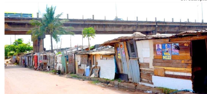
MORADORES DA PONTE JOSÉ SARNEY SERÃO REMANEJADOS
