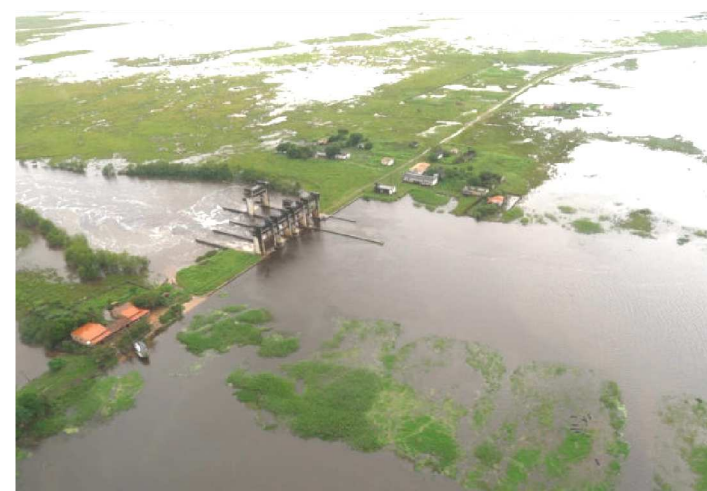
BOMBEIROS FIZERAM VISTORIAS NA BARRAGEM
