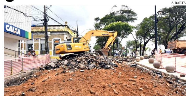
O TRABALHO FAZ PARTE DE REVITALIZAÇÃO DO CENTRO
