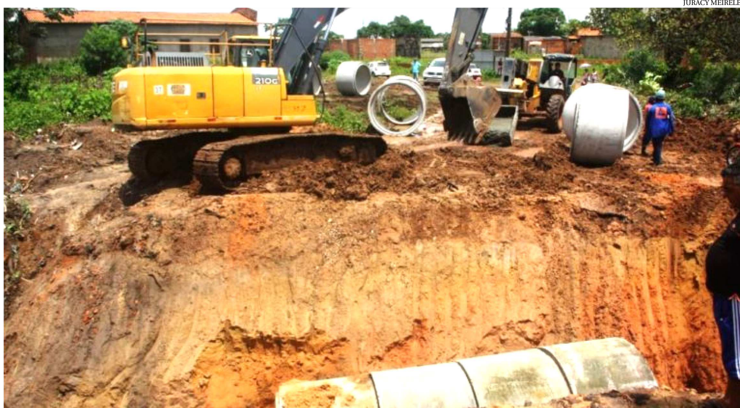
NA ANDIROBA, ONDE OCORREU ROMPIMENTO PELAS CHUVAS, ESTÁ SENDO IMPLANTADA UMA REDE DE DRENAGEM PROFUNDA
