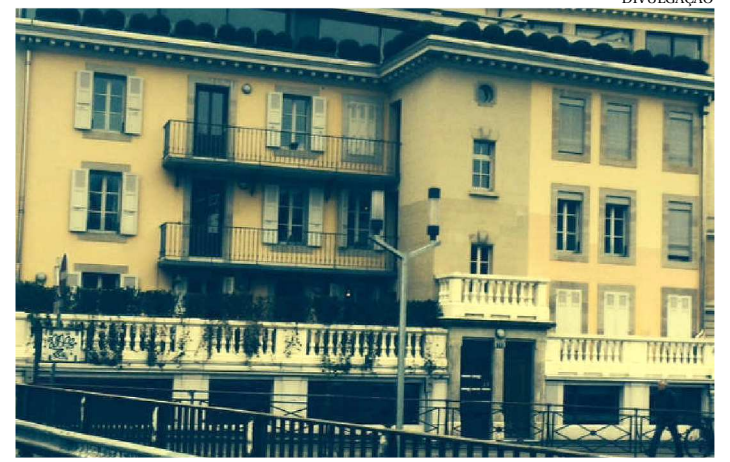
FACHADA DO PRÉDIO DO MINISTÉRIO PÚBLICO NA SUÍÇA
