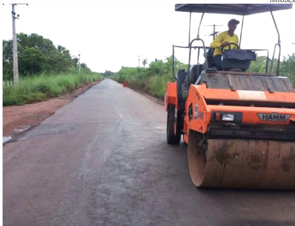
A MA-381, ENTRE JOSELÂNDIA E PEDREIRAS, ESTÁ NO TRABALHO DE RECAPEAMENTO
