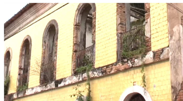
CASARÃO AMARELO FOI UM DOS IMÓVEIS VISTORIADOS
