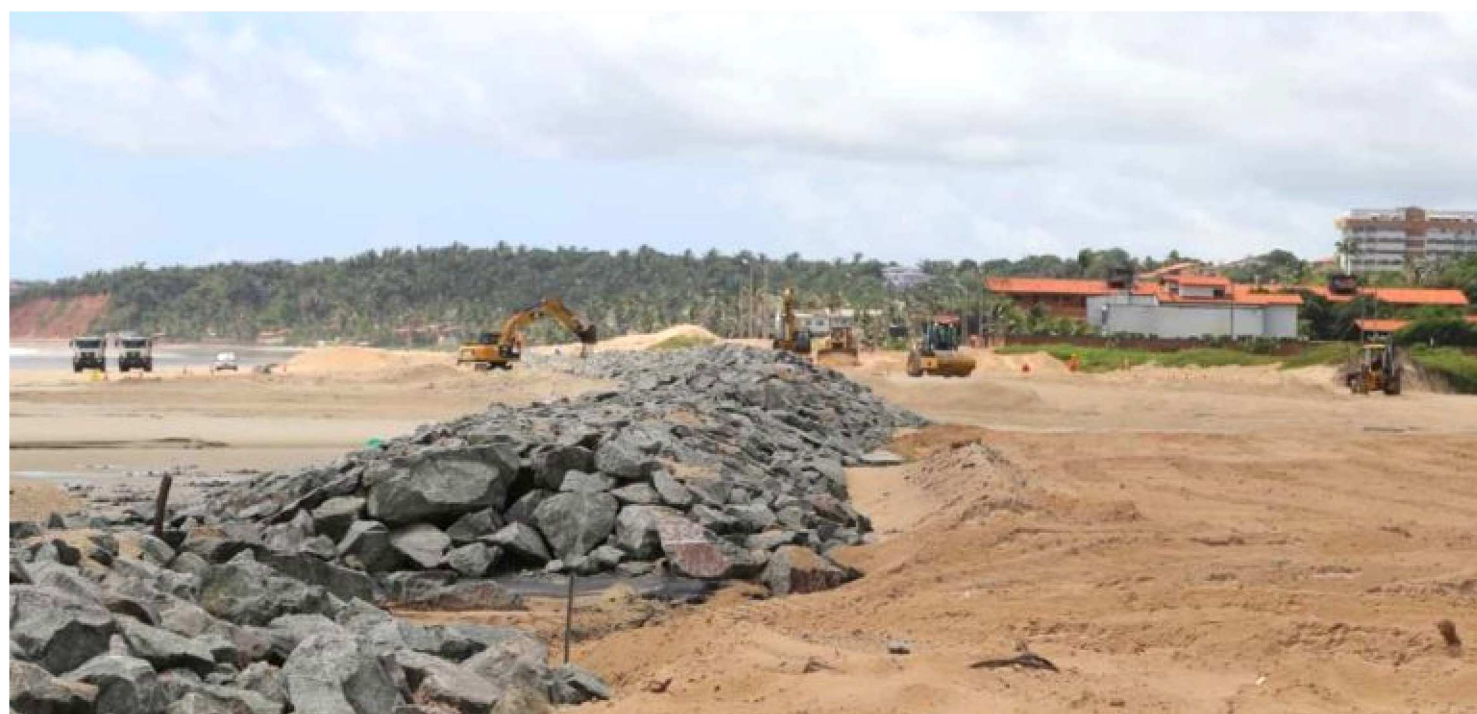
OBRAS DE PROLONGAMENTO DA AVENIDA LITORÂNEA
