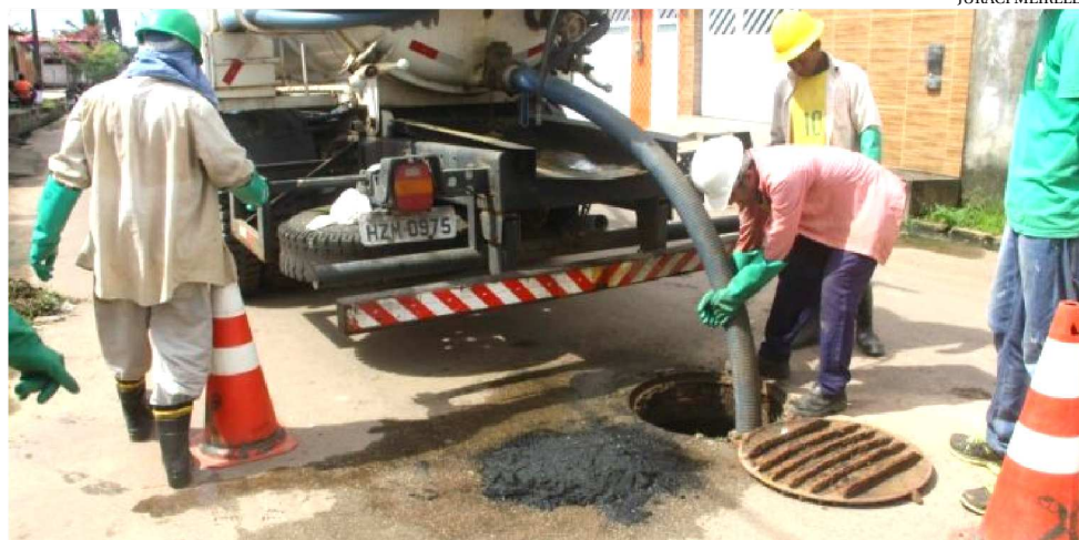
AS ATIVIDADES VISAM O ESCOAMENTO DAS ÁGUAS, PREVENINDO ALAGAMENTOS
