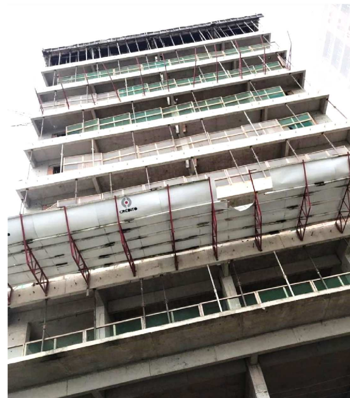
SINDCONSTRUCIVIL TINHA FEITO FISCALIZAÇÃO NA OBRA
