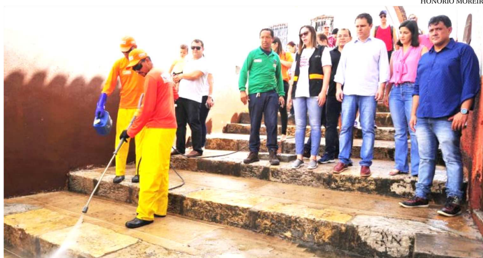
PREFEITO EDIVALDO ACOMPANHA SERVIÇOS DE LIMPEZA E DE INFRAESTRUTURA
