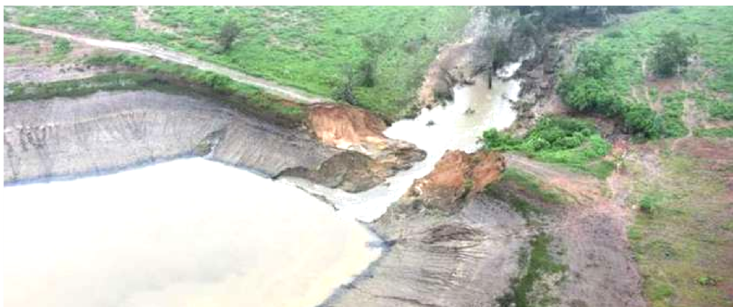
BARRAGEM DE QUATI ROMPEU NA BAHIA, INUNDOU RESIDÊNCIAS E DEIXOU CENTENAS DE DESABRIGADOS NO NORDESTE DO ESTADO
