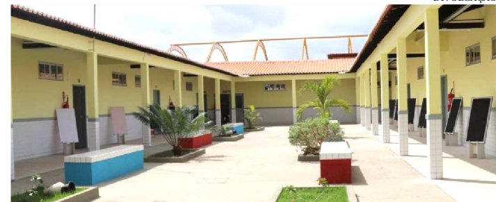
OBRAS CAUSAM IMPACTO EM ESTUDANTES E PROFESSORES
