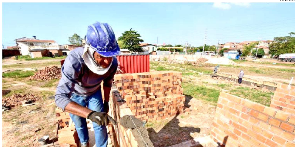
GESTÃO DO PREFEITO EDIVALDO INICIA OBRAS DE ECOPONTO E GALPÃO DE TRIAGEM
