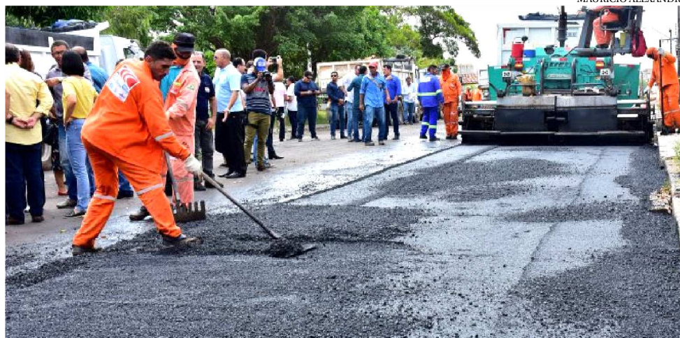
RECUPERAÇÃO ASFÁLTICA DO BAIRRO DO VINHAIS IRÁ MELHORAR A MOBILIDADE
