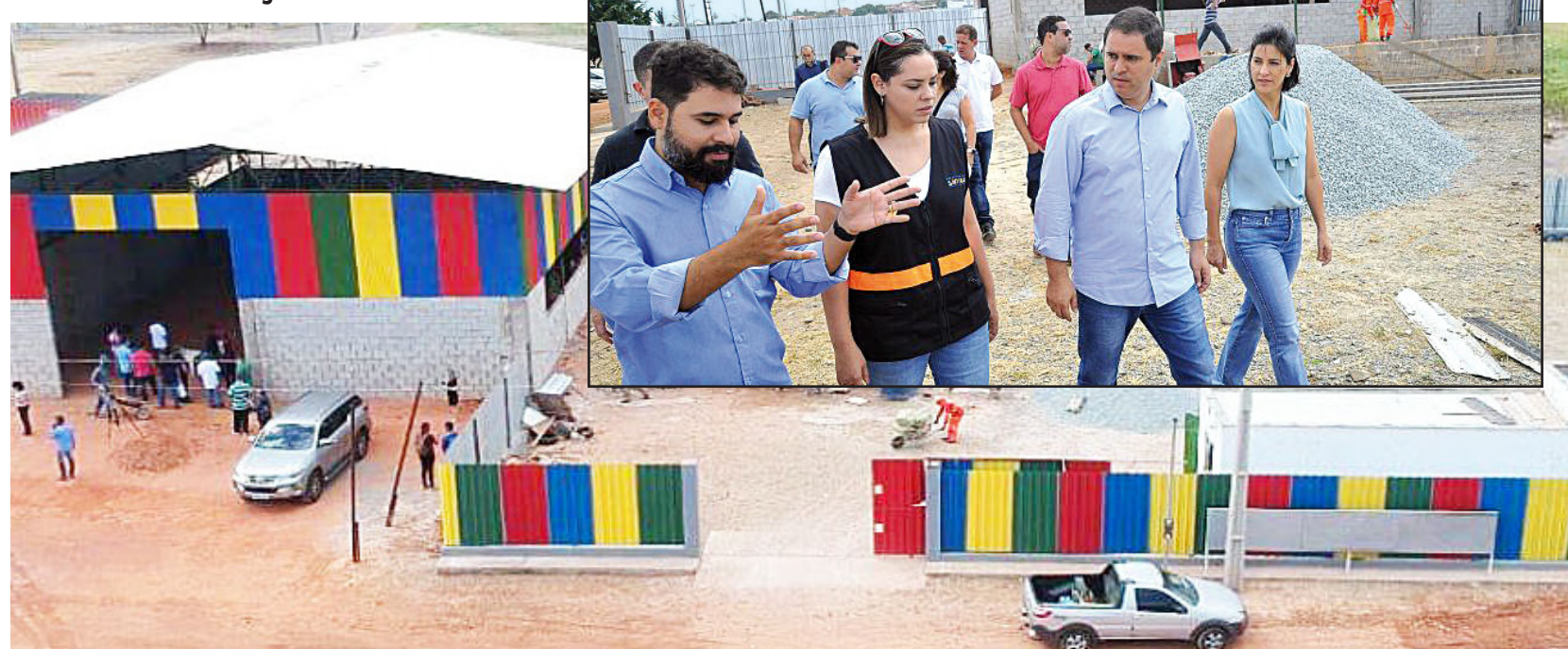
Prefeito Eivaldo vistoria obras do Galpão de Triagem de Material Reciclável
