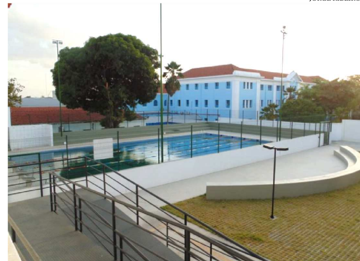
OBRAS ENLOBAM SISTEMAS ELÉTRICOS E HIDRÁULICOS
