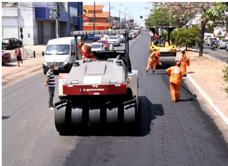
MÁQUINAS ESTÃO TRABALHANDO NA REQUALIFICAÇÃO DA AVENIDA GUAJAJARAS
