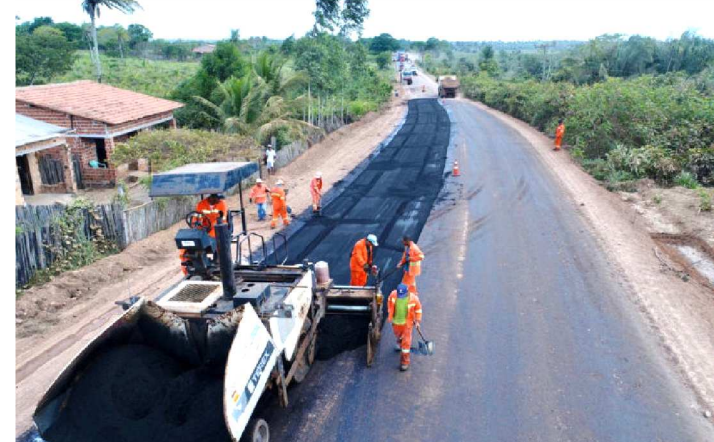
OBRA NA RODOVIA ESTADUAL ESTÁ SENDO FEITA PELA SINFRA
