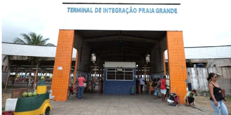
A INTERDIÇÃO PARCIAL DO TERMINAL FOI REALIZADA A PARTIR DA 00H, DE ONTEM
