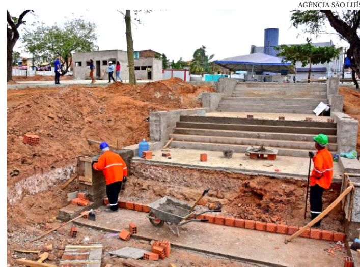
HOMENS TRABALHAM NAS OBRAS DA PRAÇA DA BÍBLIA
