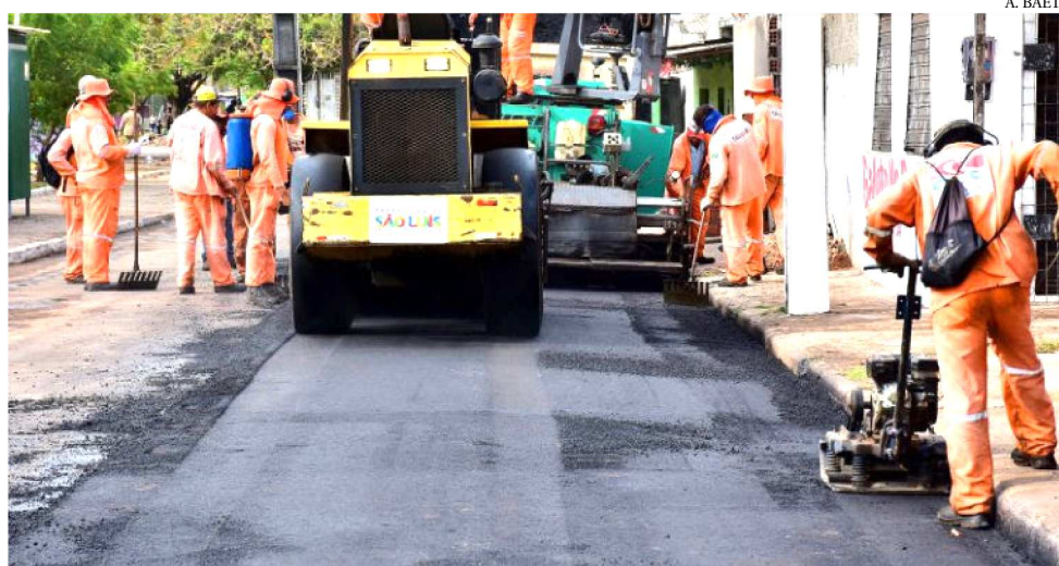
PREFEITO EDIVALDO INICIA OBRAS DE PAVIMENTAÇÃO NO ITAQUI-BACANGA
