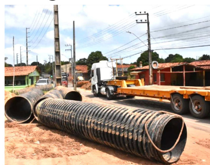
MA-204 RECEBE DRENAGEM CONTRA ALAGAMENTO DA VIAS
