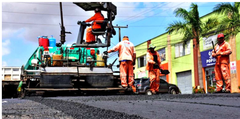
PREFEITO INICIA ASFALTAMENTO NO PARQUE UNIVERSITÁRIO E PLANALTO PINGÃO
