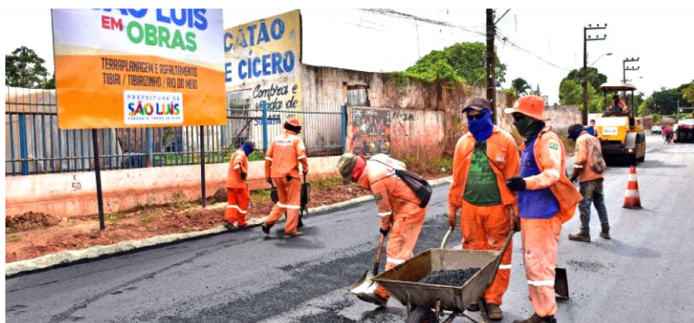
ANDAMENTO DO SÃO LUÍS EM OBRAS NA ZONA RURAL DA CAPITAL É VISTORIADO
