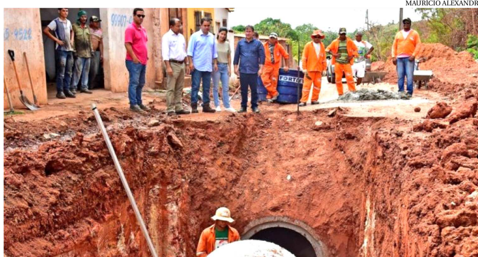
OBRAS DE DRENAGEM NO BAIRRO DO TIBIRI SÃO ACOMPANHADAS PELO PREFEITO
