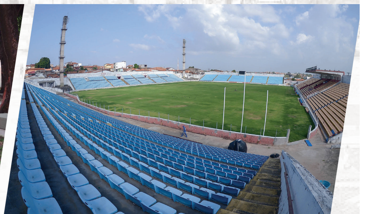
Reforma e modernização do Estádio Nhozinho Santos
