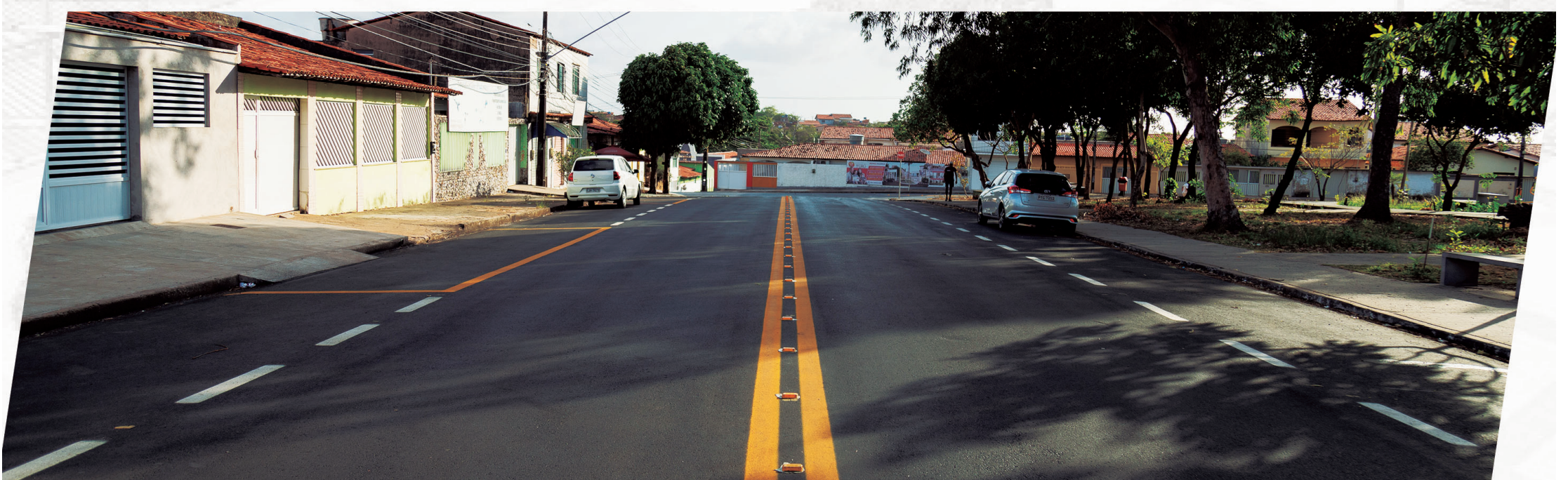
Mais de 200km de asfalto em dezenas de bairros
