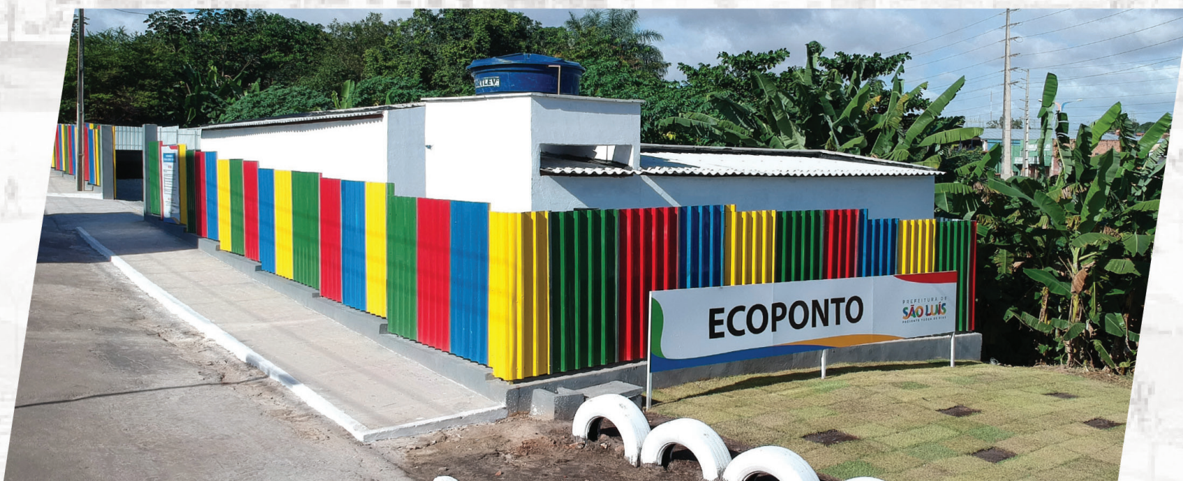
Construção de Ecopontos no Residencial Primavera, Cohaserma e Barreto além de construção de Galpões de Triagem no Centro e Vila Isabel (Itaqui-Bacanga)
