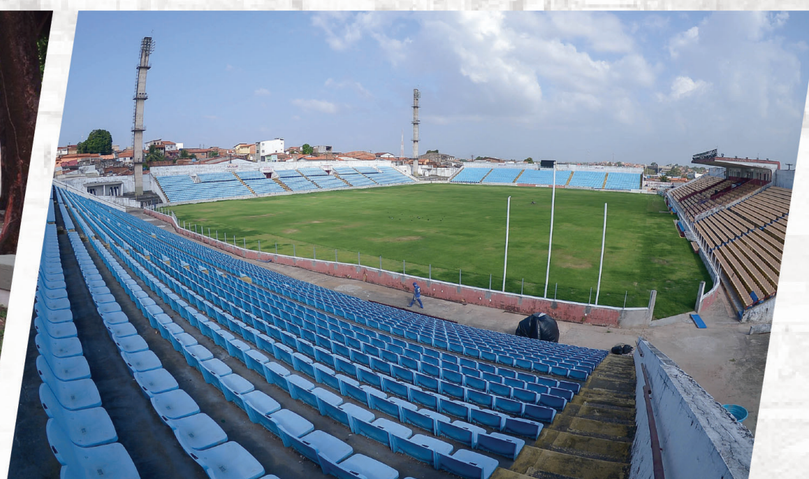
Reforma e modernização do Estádio Nhozinho Santos
